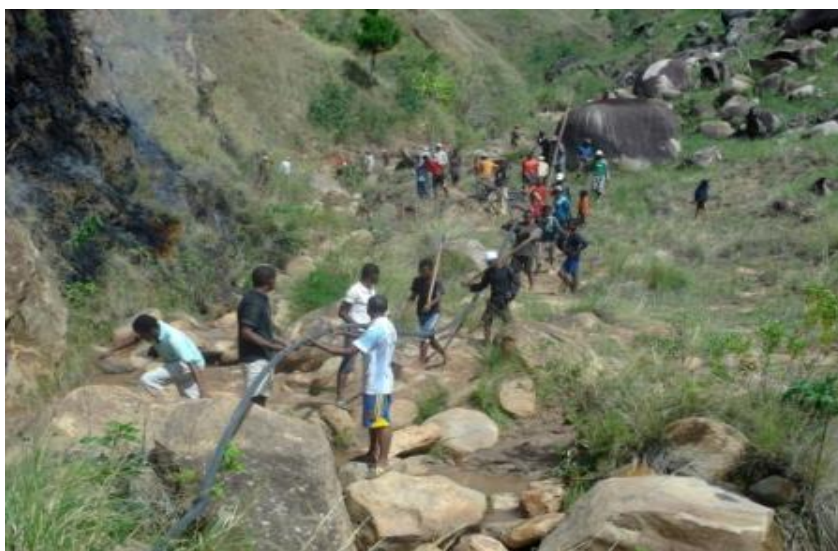
Travaux de mise en place de tuyaux, de la source aux nouvelles bornes fontaines.
