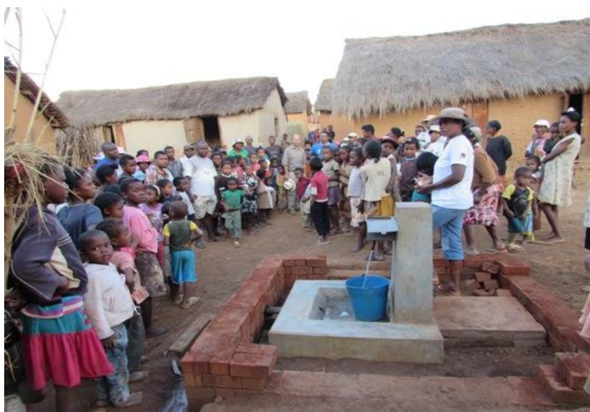
Nouvelle borne fontaine opérationnelle, le mur de clôture est en construction.
