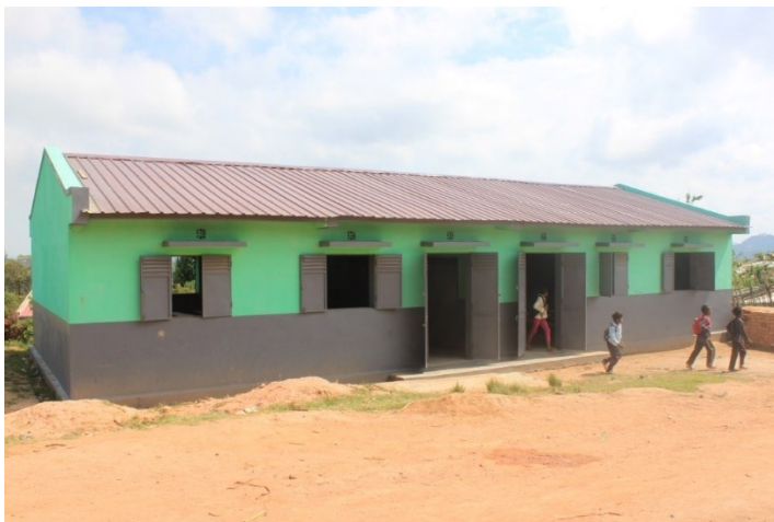
Bâtiment, deux classes, Alakamisy
