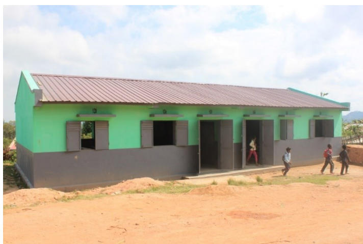
Bâtiment, deux classes, Alakamisy
